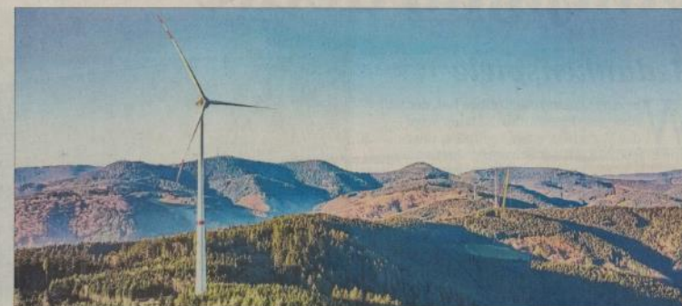
Auf dem Hohenlochen wird zur Zeit ein Windpark errichtet. Vier Windräder sollen dort Energie gewinnen. Archivfoto: Andreas Walry
